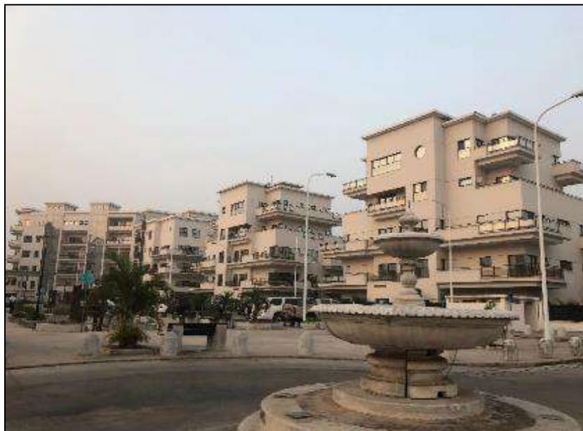
Figure 6. Logements de la Résidence du Clairon à Brazzaville
