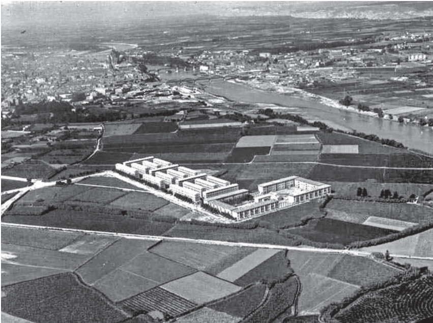
14/ "Andrea Casamayor" (Girón), project 1954-1957. Aerial view of phase 1, 1954 (Gran Archivo Zaragoza Antigua, Zaragoza).
